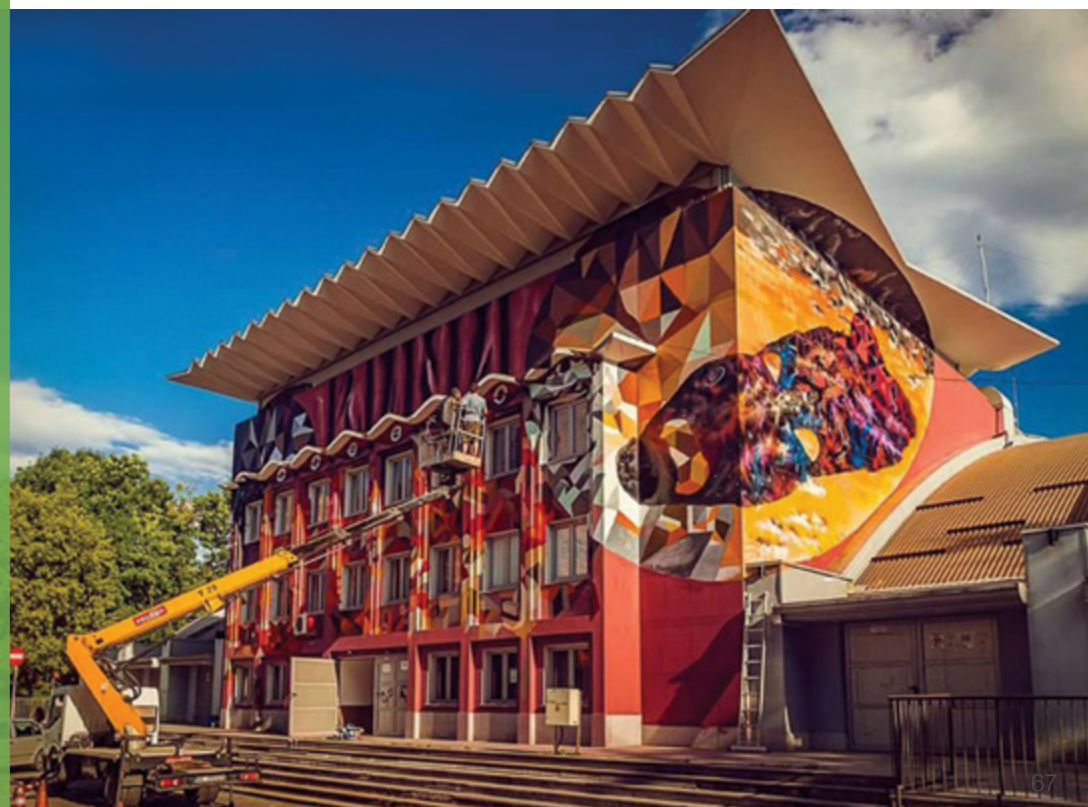
După executarea intervențiilor de regenerare urbană
