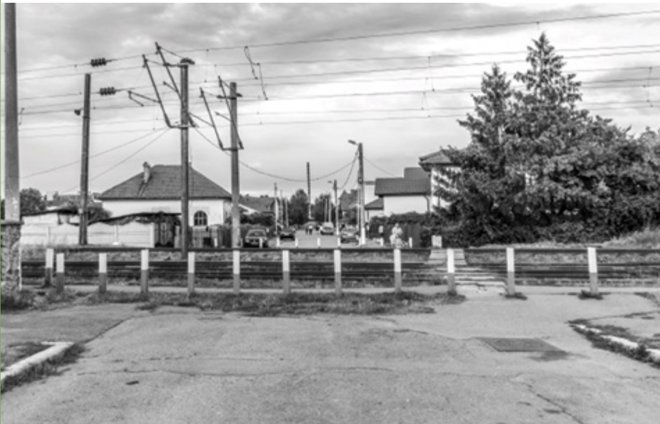
Intersecție calea ferată
